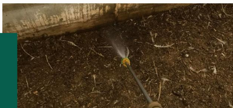
Pulvérisation sur les soubassements du bâtiment
